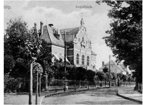
Das Landratsamt Niemöllerstraße 1, hier auf einer Postkartenansicht um 1920.
