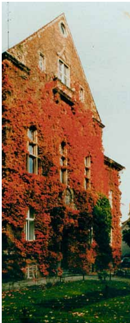
Landratsamt Niemöllerstraße 1 in Bad Belzig vor der Restaurierung
